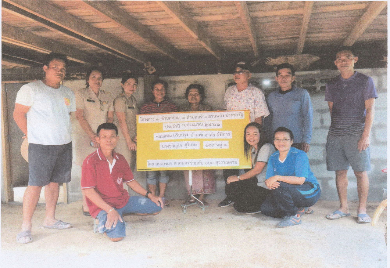
พนักงานเจ้าหน้าที่ร่วมกับผู้นำชุมชนร่วมด้วยช่วยกันซ่อมแซมบ้านผู้พิการ
