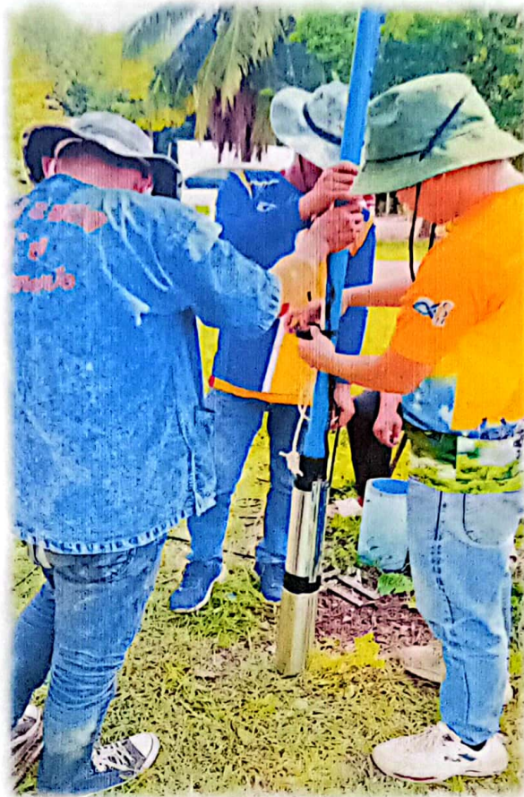
ภาพถ่ายหลังดำเนินการขอมแซมแล้วเสร็จ
