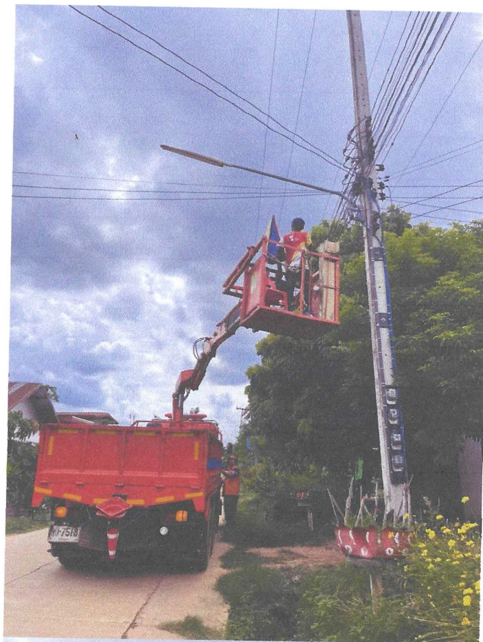
ภาพขณะดำเนินการและแล้วเสร็จ
